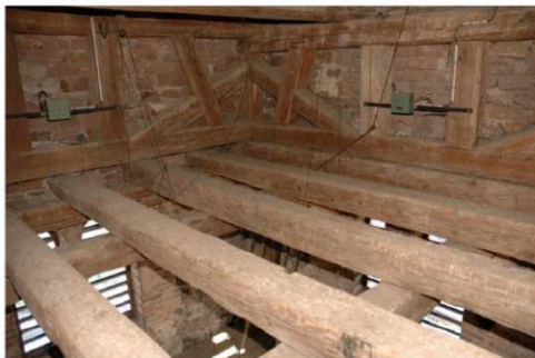
Charpente sous le beffroi
