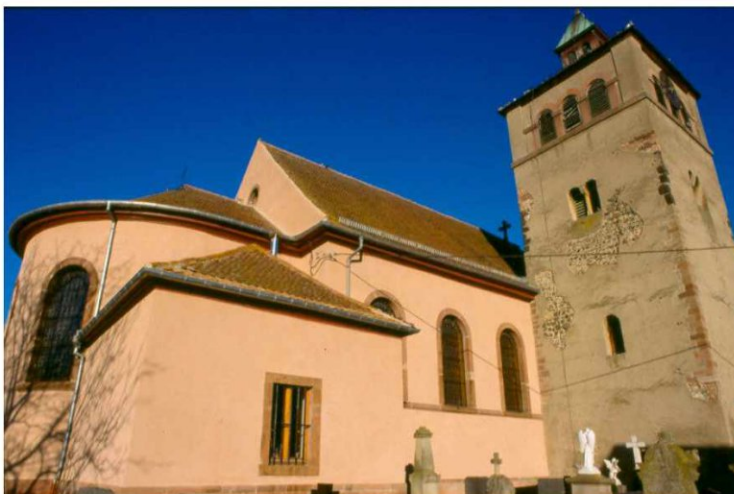
Photo prise en 1994, avant les travaux de rénovation du clocher
