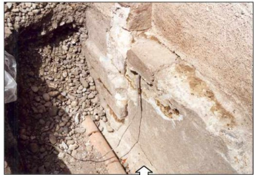
Base de l'arc triomphal. Photo prise à l'extérieur côté Ouest. Le sol de l'église se trouvait initialement (XIIème siècle) au niveau du tuyau de drainage.
